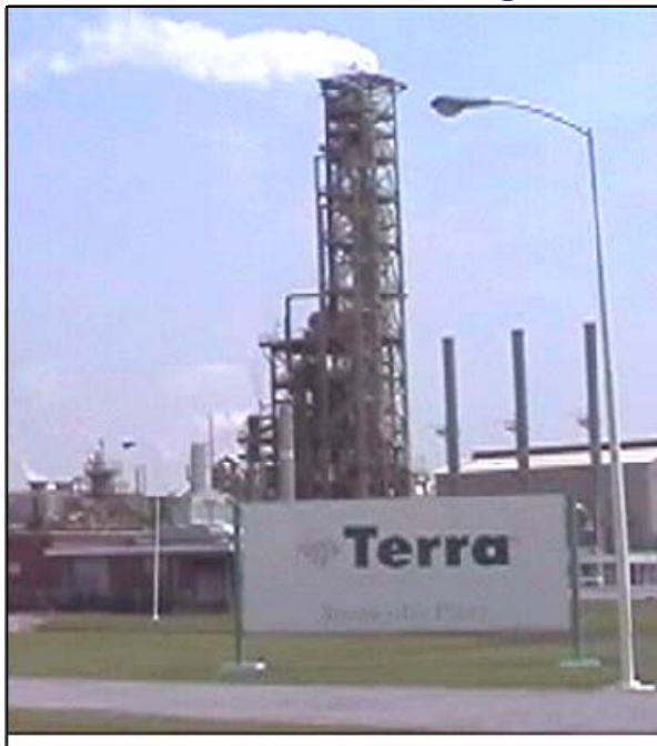
(Urea Granulation Plant)
